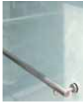
外貼り飛散防止フィルムの白化
