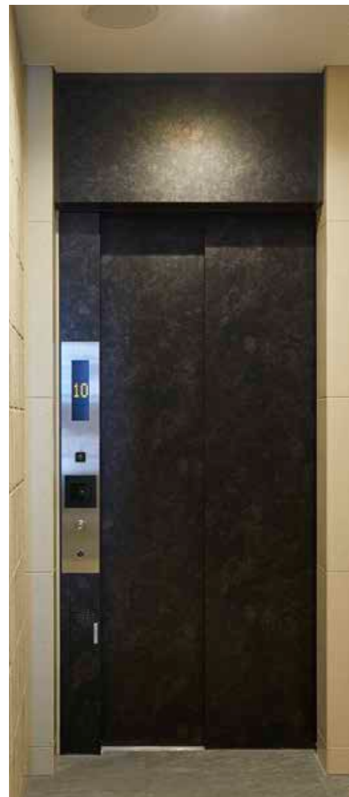
RT-1111 / 扉、扉まわり
