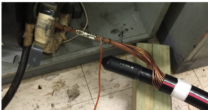
Figure 4 : Connecteur serti raccordant les fils à neutre concentrique. Le connecteur utilisé est un connecteur en aluminium 10006 2/0.
