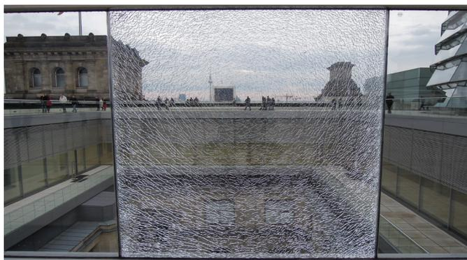
\*El estudio indica que una impureza de sulfuro de níquel con el potencial de causar rotura espontánea de vidrio ocurre en 1 de cada 4-12 toneladas de vidrio. Asumiendo que el vidrio pesa 1,4 Kgs / m<sup>2</sup> y un tamaño de ventana típico de 10 m<sup>2</sup>.
