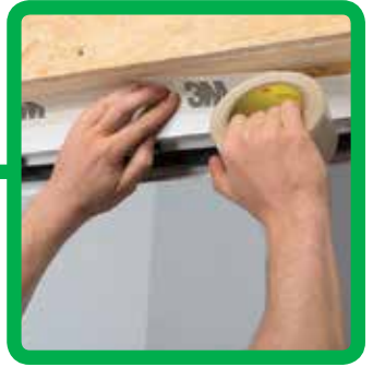
FAST-F Tiivistää kalvot kattoikkunoihin
