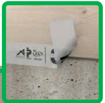
FAST-F Seinäliitosten tiivistäminen
