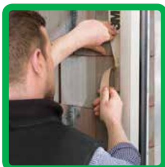
FAST-F Halkaistu suojapaperi helpottaa ovien ja ikkunoiden tiivistämistä.
