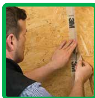
FAST-F Ilmatiivis liitosten suojaus
