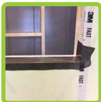
FAST-UC Ikkuna-aukkojen tiivistäminen
