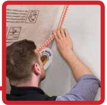
FAST-D Höyrynsulkukalvon tehokas kiinnittäminen puhdistettuun pintaan
