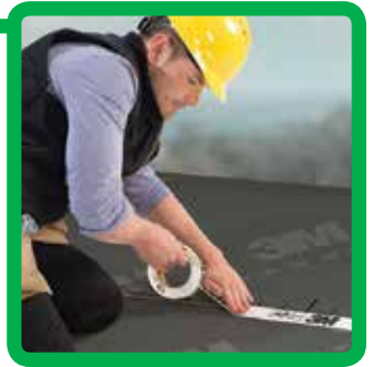
FAST-F Tiivistää välikaton kalvojen saumat ja liitokset ilmatiiviisti.
