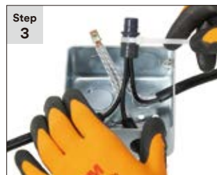
Step 3 接続部を3M™ 耐火キャップへ差し込み、 結束バンドを締め付けて固定する。 （テープ巻きは不要）
