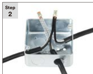
Step 2 圧着スリーブで導体を接続し、 余長を切断する。
