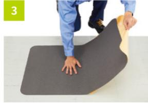
3 固定した短辺から長辺方向へ手を動かしながら剥離紙を剥がして貼っていきます。
