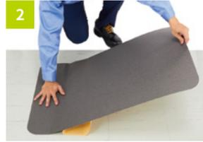
2 シートの短辺を施工する床に貼って施工位置を決めます。
