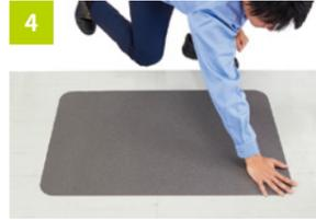
4 シート中心部から外側へ空気を逃がすように手を動かしてシート全体を床に固定して下さい。
