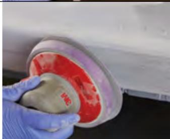
**Preparação da Superfície com Máquina**
