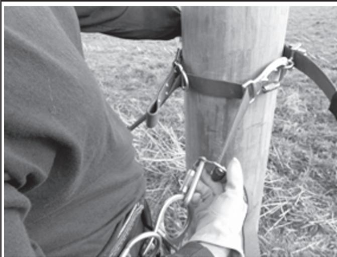
Figura 22 - Ajuste hacia delante hacia el poste, cincha
