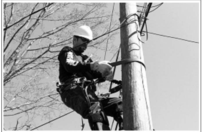
Figure 31 - Reconnexion de la sangle ou de la longe
