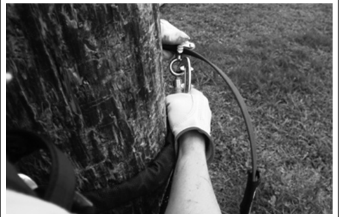
Figure 10 - Connexion au poteau
