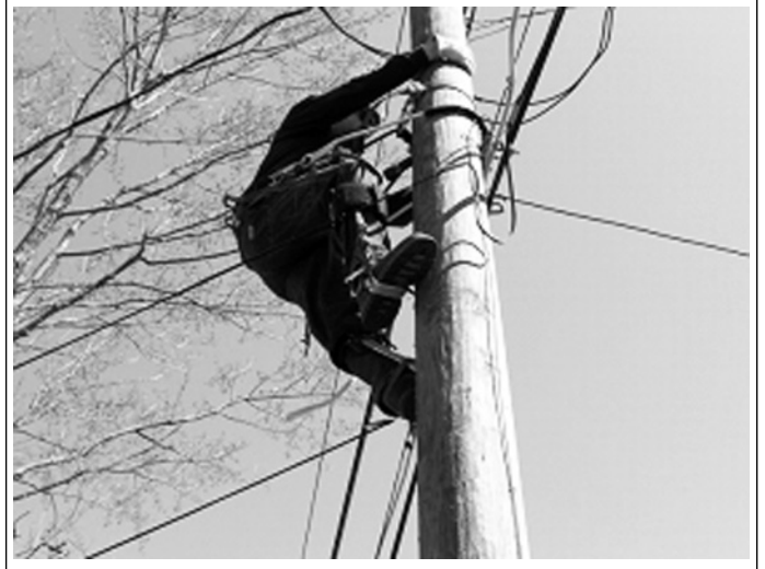
Figure 31 - Reconnexion de la sangle ou de la longe
