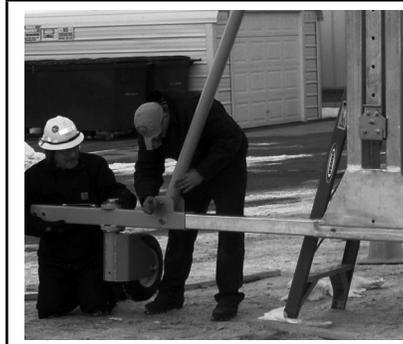
**Étape 11 :** Alignez le gousset du montant vertical avec le support de fixation sur l'assemblage de montants verticaux. Insérez le boulon, fixez l'écrou et serrez (figure 14).
