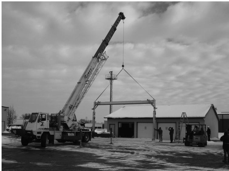
**Étape 8 :** Avec l'assemblage de portique en A soutenu par la grue (ou autre équipement approprié), insérez les deux supports de base dans les tubes de support de base de l'assemblage de montants verticaux (figure 12).
