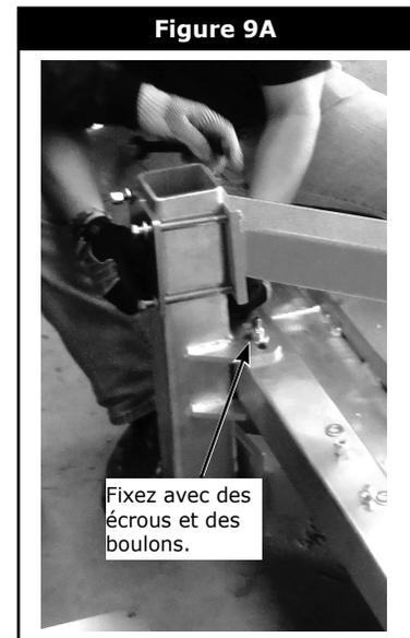
**Étape 5 :** Une fois que tous les goussets de support de rails ont été installés, serrez les écrous et les boulons (qui les maintiennent sur les supports de fixation) selon les spécifications appropriées (tableau 2).
