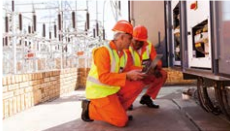
プラントメンテナンス作業
