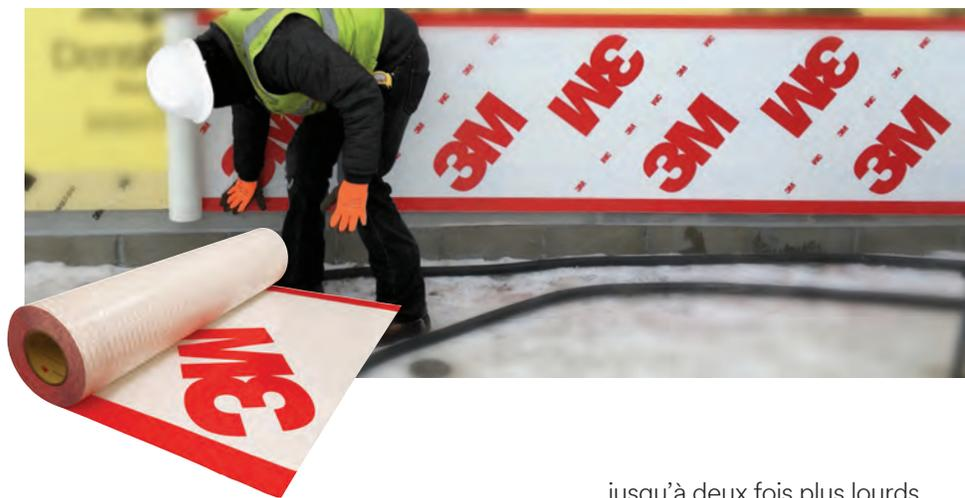
Conçue pour que l'application de pare-air soit simple et rapide, cette membrane pare-air perméable à la vapeur contribue au contrôle plus efficace du climat intérieur.
