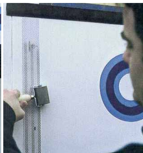
Dégraissez avec de l'isopropanol ou le 3M Surface Preparation System
