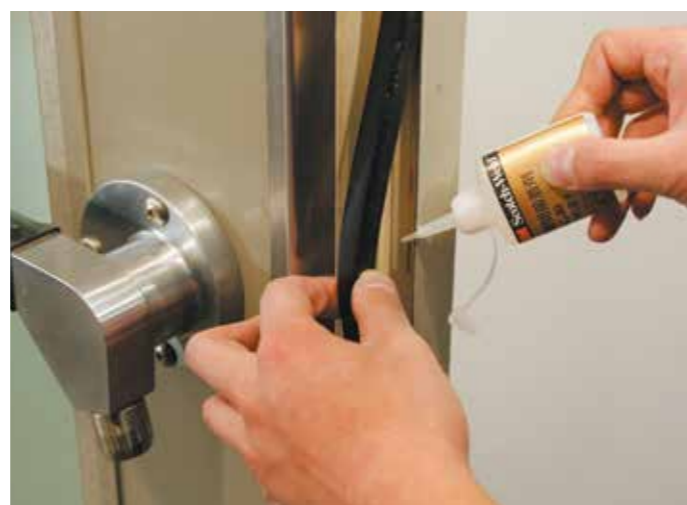
● 建築用EPDMパッキン材・緩衝材の接着
