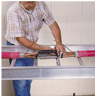
Рис.11. Монтаж ленточной соединительной муфты на кабеле с изоляцией из сшитого полиэтилена и медным ленточным экраном с применением лент компании 3М, в том числе с помощью ленты Scotch® 23
