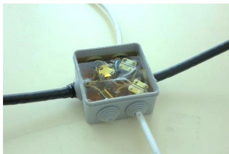
Рис. 20 Компаунд полностью покрывает соединения, можно подавать напряжение
