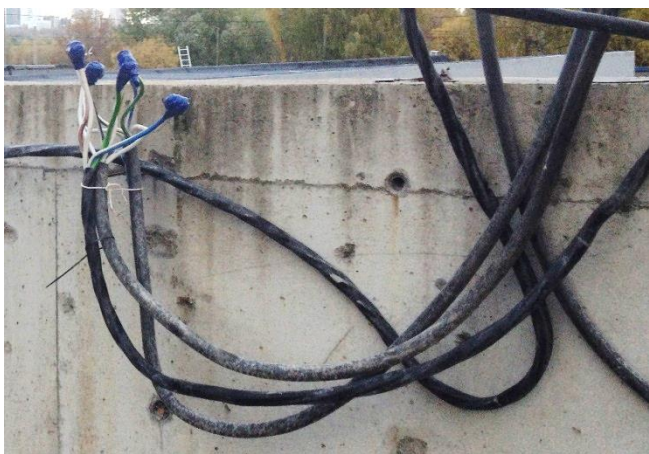
Рис. 22 Изоляция кабеля с помощью изоленды
