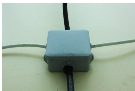
Рис. 21 Коробка закрывается крышкой для защиты от внешних воздействий
