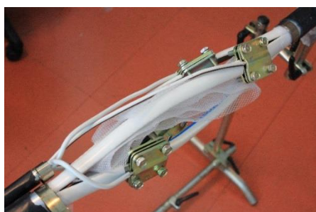
Рис. 10 Прокладывание сетчатой ленты между жилами кабеля для лучшего сцепления с компаундом
