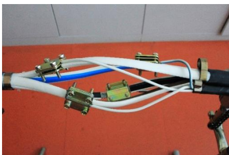
Рис. 9 Соединение жил магистрального и ответвляемого кабелей при монтаже муфты 3M™ GTS
