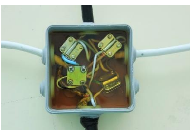
Рис. 16 Распаячная коробка с ответвлением кабеля, залитая удаляемым желеобразным компаундом Scotchcast® 2123
