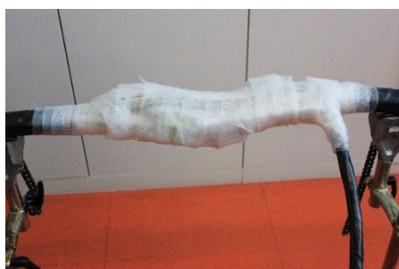
Рис. 11 Формирование корпуса муфты из сетчатой ленты
