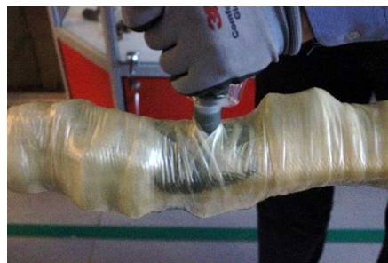
Рис. 14 Заливка компаунда в корпус. Компаунд заполняет пространство между слоями сетчатой ленты, а прозрачная лента предотвращает вытекание компаунда
