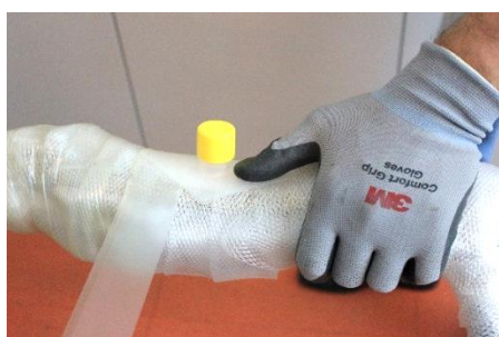
Рис. 12 Установка приемного клапана для заливки компаунда
