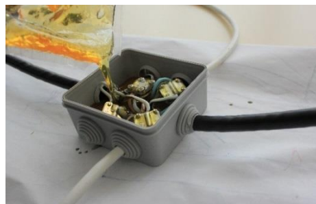
Рис. 19 Заливка удаляемого компаунда в распаячную коробку для герметизации соединений
