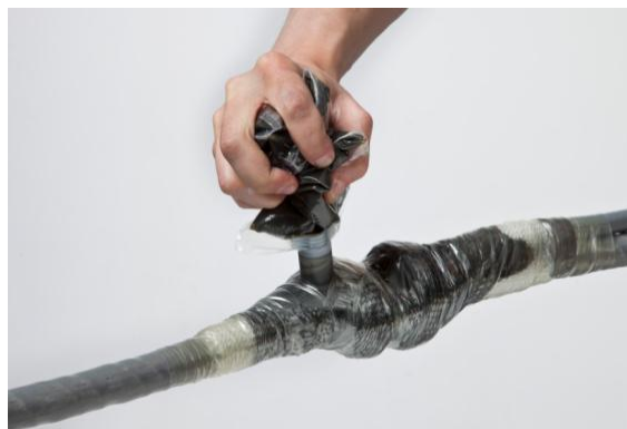
Рис. 8 Процесс заливки компаунда в корпус муфты 3М™ GTS
