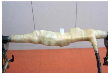
Рис. 13 Корпус муфты обмотан прозрачной лентой поверх сетчатой
