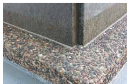
建材パネルのシール
