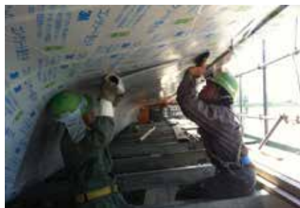
橋梁での貼り合わせ作業
