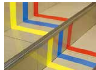
段差部への標示（なじみ性）
