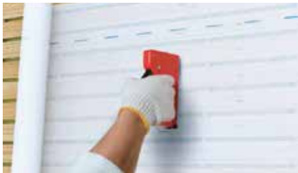
外壁での施工例
