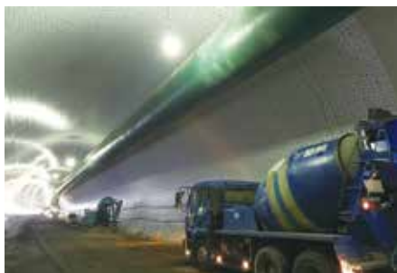
トンネル壁面
