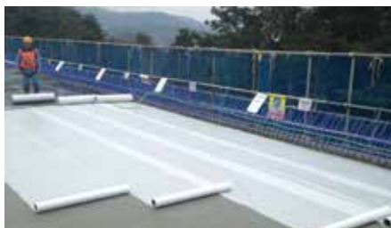
コンクリート給水養生用 水搬送シート敷設現場
