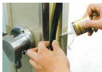
建築用EPDMパッキン材・緩衝材の接着
