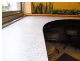
カウンターパネルの組立
