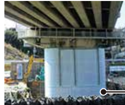
耐震補強・コンクリート巻き立て工
