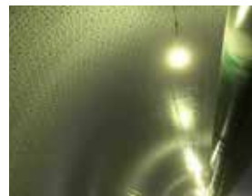
トンネル壁面
