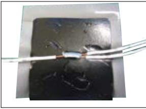
パッドの中央に ワイヤー接続部を置く
