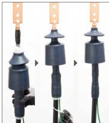
3. 端子取付け後、端末外被を装着
