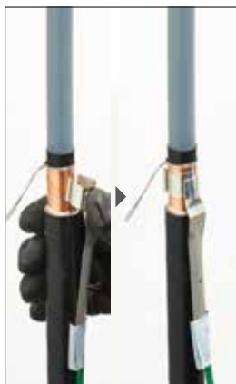
1. 接地用クランプの取付け
