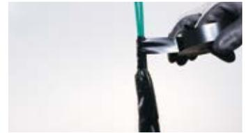
4 セパレートパックの上部をビニルテープで巻き固定する。
