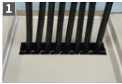
1 ケーブルを敷設する
