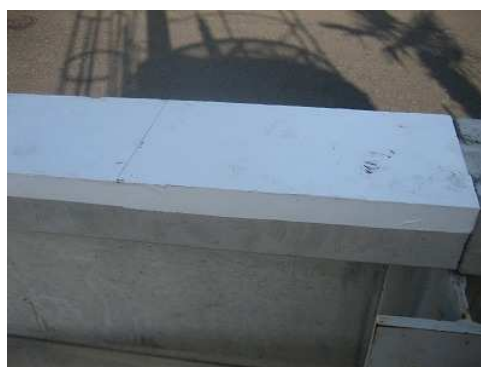
写真 3. 上部の処理部分拡大
