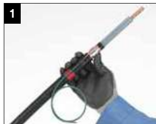
接地クランプの取付け。
