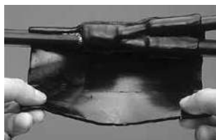
2. 絶縁パテシート（大）（小）の 巻き付け分岐線の結束
