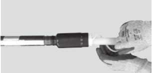
2 電解緩和材料入りチューブの装着。
