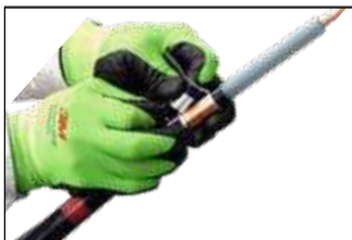
1. 接地クランプの取付け。
