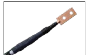
4. 端子取付け後、充電部をテープで防水処理し、完成。
