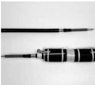
1. ケーブルを段剥き処理し、絶縁筒本体をケーブルに挿入する。
