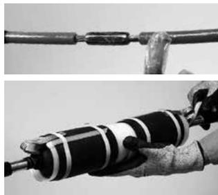
2. 導体接続子を圧縮し、専用グリースをケーブル絶縁体上に塗布する。規定の位置に絶縁筒を装着する。ここでは黄色リボンを引抜く。
