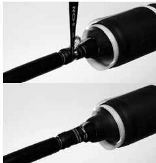
4. 平編組銅線の余長を切断し、金属露出部全体にスコッチ® 半導電性テープ 13 を1往復巻く。
