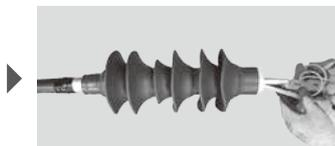
3 端子を取付け後、常温収縮チューブを装着する
