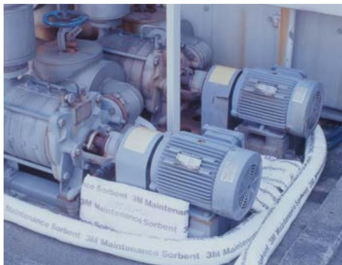
ポリオレフィン系不織布を主材料とした耐薬品性に優れた吸収材です。酸・アルカリやオイル・有機溶剤などの多様な液体危険物を吸収します。
