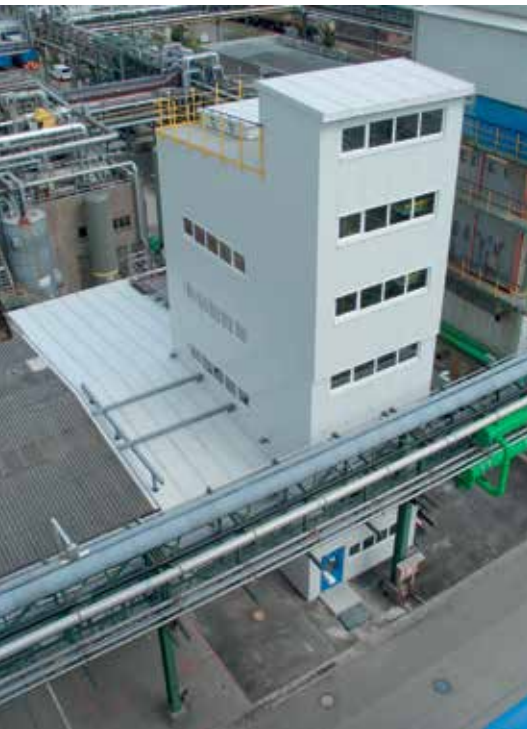
Bild 1. Pilotanlage von Dyneon für Up-Cycling von End-of-Life-Fluorkunststoffen mit einer Kapazität von 500 t/a (Bilder: Dyneon)
