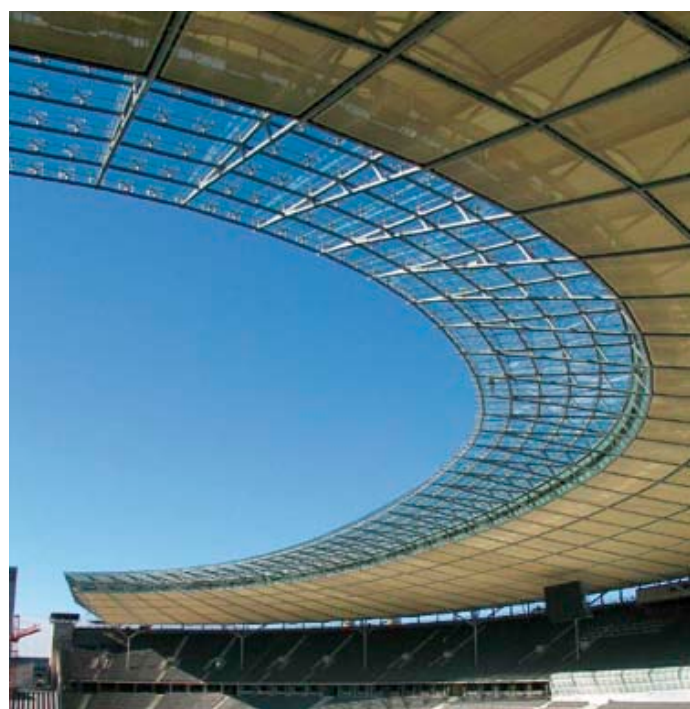
Abb. 2: Berliner Olympiastadion mit seiner leichten Membrandachkonstruktion (Foto: Hightex GmbH)
