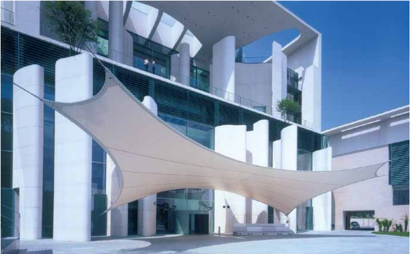
Das elegante Dach mit Dyneon PTFE beschichtetem Glasfasergewebe setzt Akzente im Ehrenhof des Bundeskanzleramts. PTFE macht den größten Anteil unter den verbrauchten Fluorpolymeren aus (© 3M, Foto: Werner Huthmacher)
