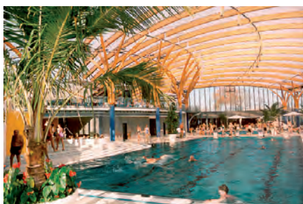
Abb. 6: Leichte, ansprechende Dachkonstruktionen aus ETFE-Folien können mithelfen, Bauwerke besonders ansprechend zu gestalten und Gäste anzuziehen, hier z. B. ins Schwimmbad Prienavera in Prien am Chiemsee.
