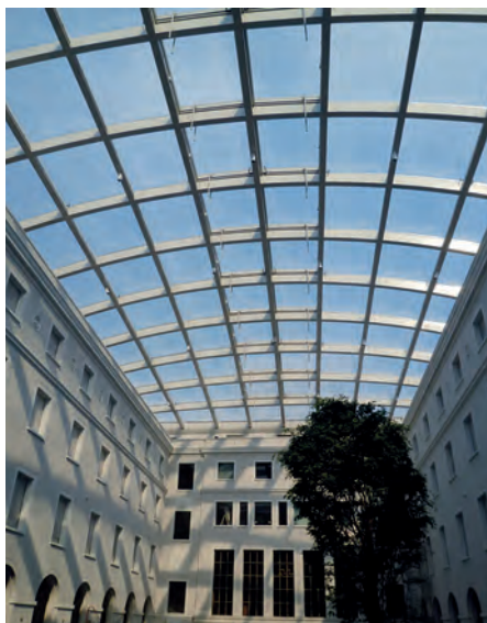
Abb. 3: Der Innenhof des William Rappard Centres der World Trade Organisation in Genf ist mit Nowoflon ET 6235Z-Folien aus ETFE überspannt. Unter der selbstreinigenden, transparenten Konstruktion können sogar Pflanzen gedeihen. (Copyright: WTO)
