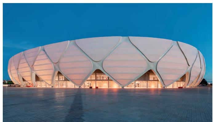
Abb. 5: Sportstadien – hier das WM-Stadion in Manaus, Brasilien – sind ein beliebtes Einsatzfeld für Membranen beschichtet mit PTFE. (Copyright: M. Bredt)
