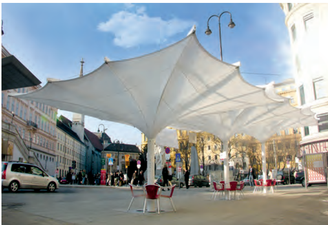
Abb. 1: Die Sonnenschutz-Segel des Cafés Mozart in Wien, Österreich, bestehen aus einem vergilbungsbeständigen, transluzenten PTFE-Gewebe
