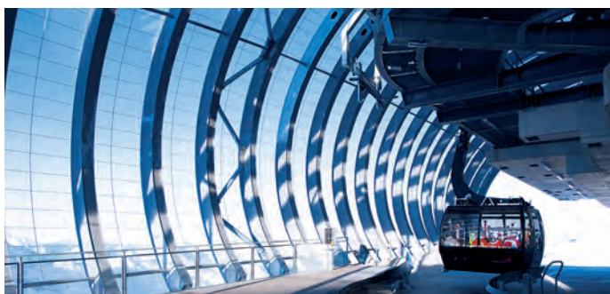
Abb. 7: Die Fassade der Gipfelstation der Gletscherbahn auf dem Gaislachkogel, Österreich. ETFE-Folien (Nowoflon ET 6235Z) halten hier den extremen Windlasten sowie der hohen UV-Belastung und den tiefen Temperaturen stand. (Copyright: A. Niederstrasser)
