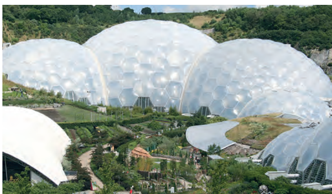
Abb. 8: Die Biome des Eden-Projects in Cornwall, Großbritannien, bestehen aus einer Kissenkonstruktion aus ETFE-Elementen. Folien aus Dyneon ETFE lassen 90 % des sichtbaren Lichts und 80 % des auftreffenden UV-A-Lichts passieren.
